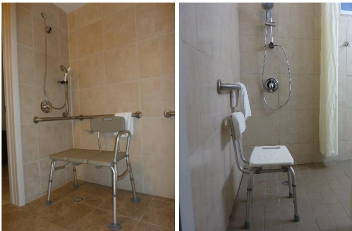
Fotos 92 y 93: Ducha a nivel con regadera tipo teléfono que se adapta a diferentes alturas para ampliar el uso a todo tipo de usuarios y sus necesidades de altura.
