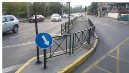
Foto 7 y 8: Medianas con protecciones laterales. En este caso falta la advertencia podotáctil en el inicio y término del cruce.
