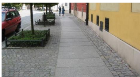
Foto 1: Ruta accesible en vereda, diferenciada a través de un pavimento estable del resto de la acera de adoquines.
