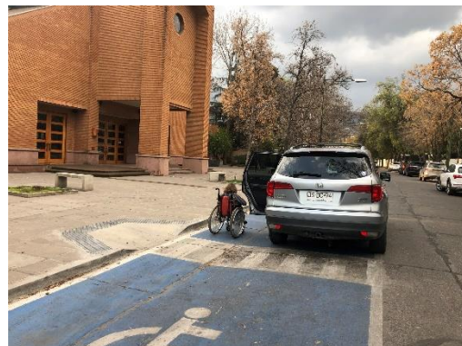
Foto 28: Estacionamientos para PcD conectado a la vereda mediante un rebaje con alas.
