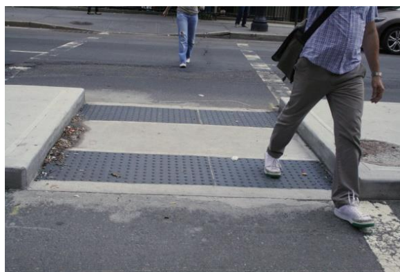
Fig. 12: Mediana de ancho menor a 6 m que mantiene todo el ancho del cruce al nivel de la calzada. Foto 5: Mediana rebajada a nivel de la calzada con pavimento de alerta en el inicio y término de ésta.
