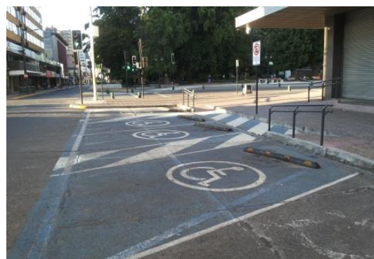
Foto 29: Estacionamientos para PcD en diagonal y conectados a la vereda
