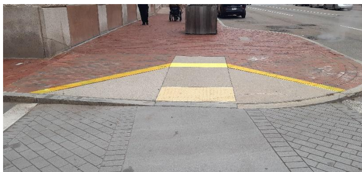
Fig. 10: Modelo de cruce peatonal de 3 pendientes con placa podotáctil de alerta en el encuentro rampa y calzada. Foto 4: modelo de rebaje al 6% de pendiente con placa podotáctil en el encuentro de la rampa y calzada.
