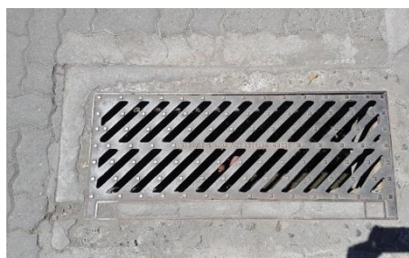
Foto 14 (izq): Rejillas dispuestas peligrosamente a favor de la circulación peatonal pueden causar atascos de las ruedas. Foto 15 (centro): El diseño de rejilla permite su instalación en cualquier sentido impidiendo el atasco de ruedas de una silla o coche. Foto 16 (der): Protección de taza de árbol correctamente enrasada y de color contrastante con su entorno.
