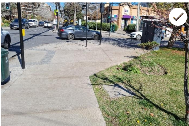
Fig. 19 (arriba): alternativa de ampliación en esquina para dar el espacio plano que se requiere al inicio de la rampa del rebaje.
