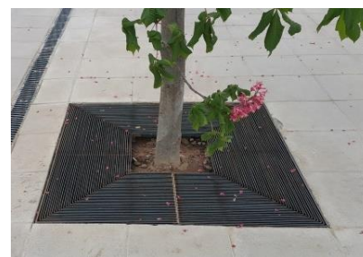
Foto 14 (izq): Rejillas dispuestas peligrosamente a favor de la circulación peatonal pueden causar atascos de las ruedas. Foto 15 (centro): El diseño de rejilla permite su instalación en cualquier sentido impidiendo el atasco de ruedas de una silla o coche. Foto 16 (der): Protección de taza de árbol correctamente enrasada y de color contrastante con su entorno.
