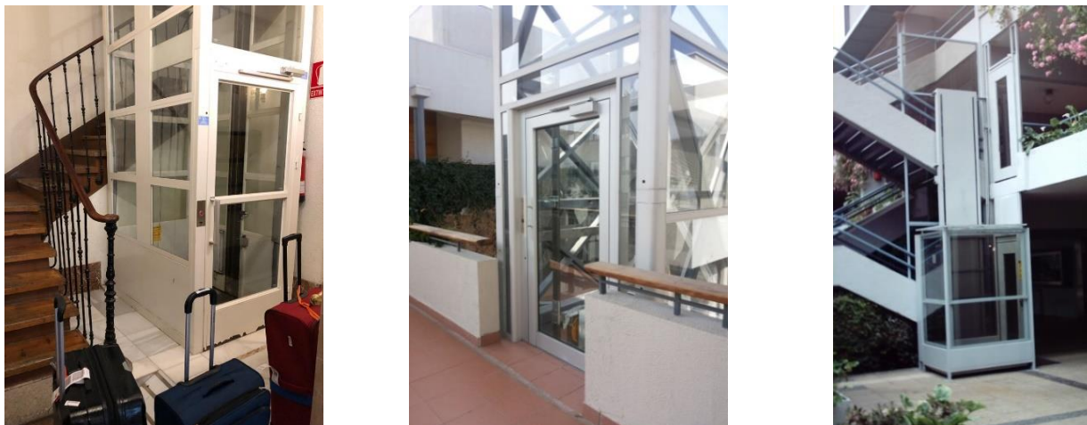
Foto 60, 61 y 62: Elevadores de tipo “especiales para personas con discapacidad” para ser instalados únicamente en locales escolares, viviendas o edificios existentes destinados a servicios. Ver definición “Ascensor especial”**
