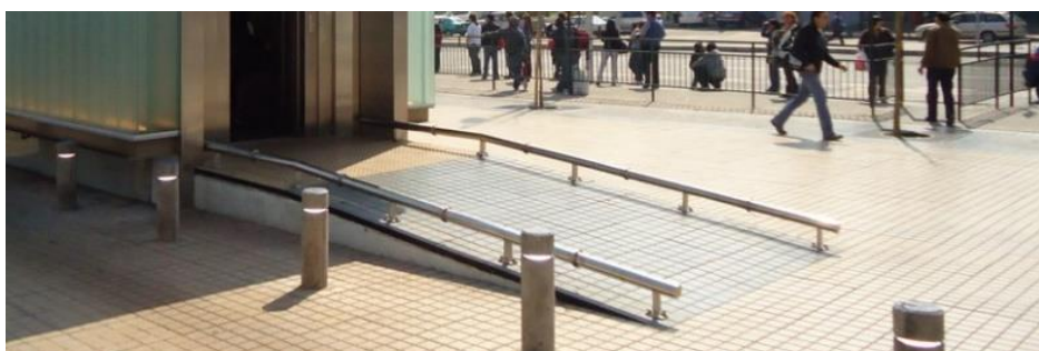
Foto 55: Rampa con protección lateral.
