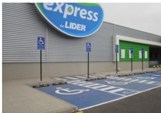
Fotos 27: Estacionamientos para PcD conectado a través de una vereda que comunica al acceso.
