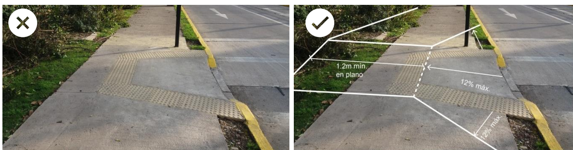
Foto 10 y 11: Ejemplo de cruce peatonal de 3 pendientes al cual se debe añadir espacio de la acera para sumar los 1,2m adicionales en plano que se requieren después del cruce.
