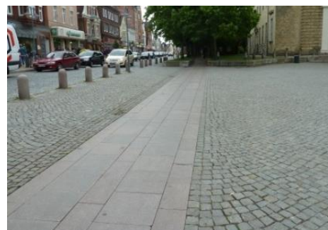
Fotos 43 y 44: El pavimento irregular del entorno hace necesario un cambio de pavimento más estable en el ancho de la ruta accesible.
