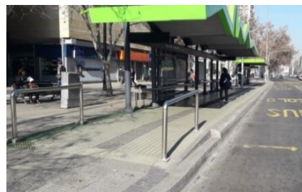
Fig. 28: Paradero a desnivel con la vereda y conectado a través de una rampa con la ruta accesible.
