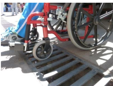
Foto 14 (izq): Rejillas dispuestas peligrosamente a favor de la circulación peatonal pueden causar atascos de las ruedas. Foto 15 (centro): El diseño de rejilla permite su instalación en cualquier sentido impidiendo el atasco de ruedas de una silla o coche. Foto 16 (der): Protección de taza de árbol correctamente enrasada y de color contrastante con su entorno.
