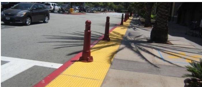
Foto 22 (izq) y Foto 23 (der): bolardos de adecuado contraste cromático y alineados al borde de la calzada
