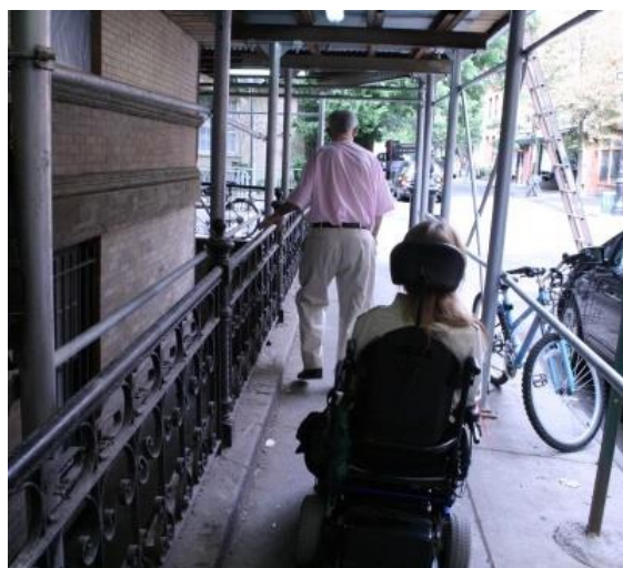
Foto 37: Área de circulación mantiene condiciones accesibles durante los trabajos.
