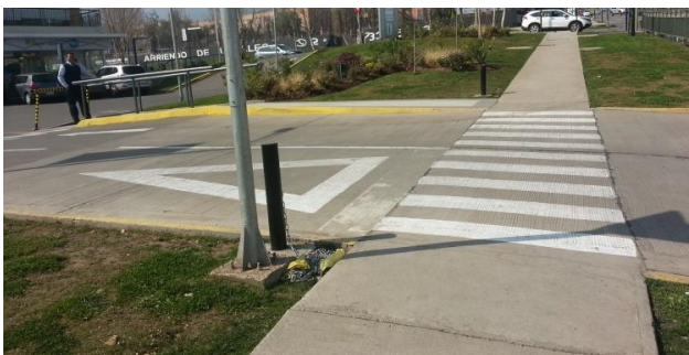
Fig. 42: Refugio peatonal entre accesos vehiculares. En accesos vehiculares de alto flujo se recomienda añadir una franja táctil de alerta perpendicular y en todo el ancho de la circulación.
